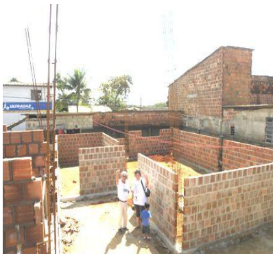
第2期の工事現場
