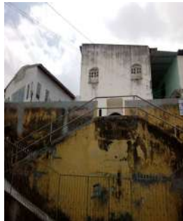
下から見ると急勾配だが。
