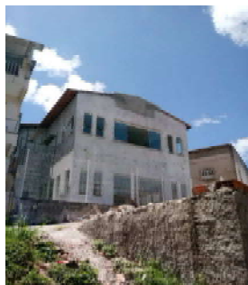
2階の内装部分まで完了。
